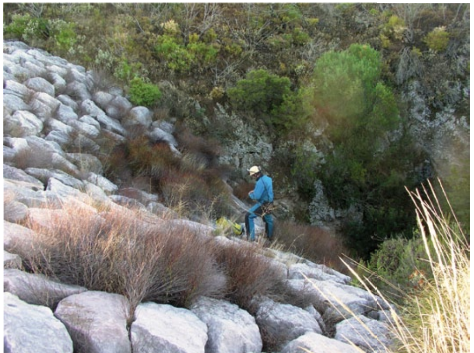
Acceso a la boca de entrada de la cavidad (se puede observar el inmenso mando y muro de escollera que se realizó).
